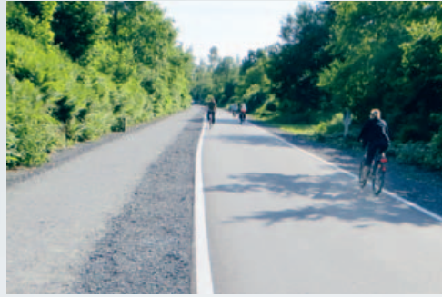
Der Radschnellweg Ruhr bei Essen – auf eine ebene Oberfläche wurde großer Wert gelegt 96
